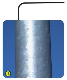
1- Le poteau est en acier galvanisé, diamètre 114,3 mm.
