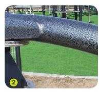
2- Le tube est en acier peint, d'un diamètre de 60 mm.
