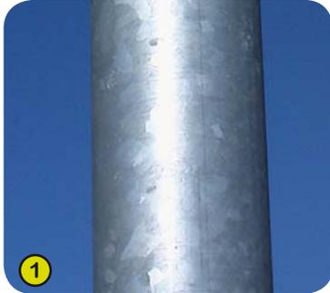
1- **Le poteau en acier galvanisé** a un diamètre de 110 mm.
