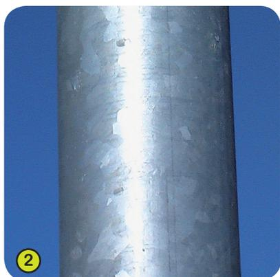
2- **Le poteau en acier galvanisé** a un diamètre de 114,3 mm.
