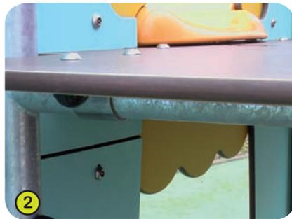
2- **Les planchers** sont usinés dans des panneaux compact structurés et antidérapants d'une épaisseur de 12,5 mm et sont renforcés par un châssis composé de tubes en acier galvanisé, Ø 40 mm.
