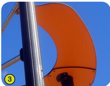
3- **Les toits** sont composés de plaques colorées élaborées à partir d'un matériau compact d'une épaisseur de 13 mm. Composé de 70% de fibre de bois tendre et de 30% de résine thermodurcissable, celui-ci présente une excellente résistance aux intempéries.
