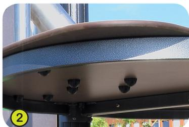
2- **Les planchers** sont usinés dans des panneaux compact structurés et antidérapants et ont une épaisseur de 12,5 mm. Ils sont renforcés par un châssis composé de tubes en acier galvanisé peint.
