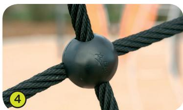
4- **Les éléments de cordage** sont réalisés avec du câble acier galvanisé recouvert de polyester. **Des sphères** en polyamide injecté assurent la liaison et le maintien des câbles.
