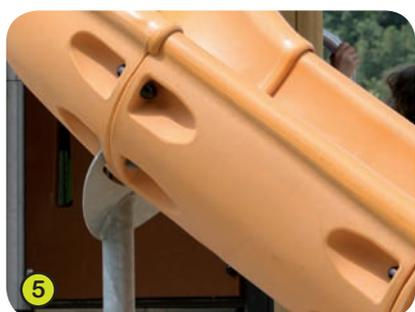
6- **Les fixations** en acier inoxydable sont protégées par des capsules anti-vandalisme en polyamide.
