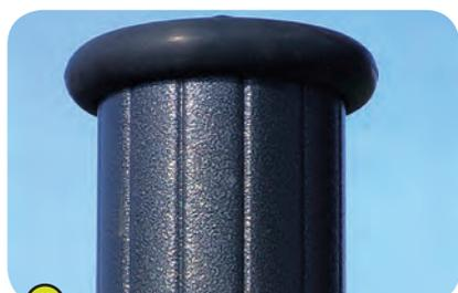
2- **Les poteaux**, diamètre 125 mm, et **les poteaux centraux**, 95 x 95 mm, sont en acier galvanisé laqué. La finition granitée en deux tons de gris présente de légers reliefs et confère une meilleure résistance aux rayures.
