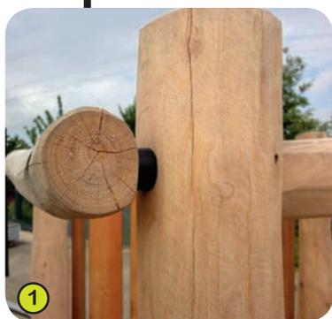
1- **Les poteaux** de diamètres variables, 6 à 8 cm / 10 à 12 cm / 12 à 14 cm, sont en robinia sans aubier, écorcé et poncé.
