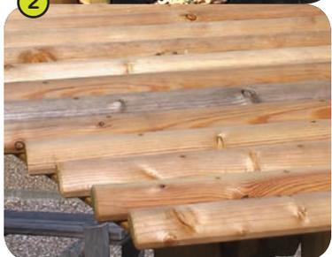
5- **Les fixations** en acier inoxydable sont protégées par des capsules anti-vandalisme en polyamide.
