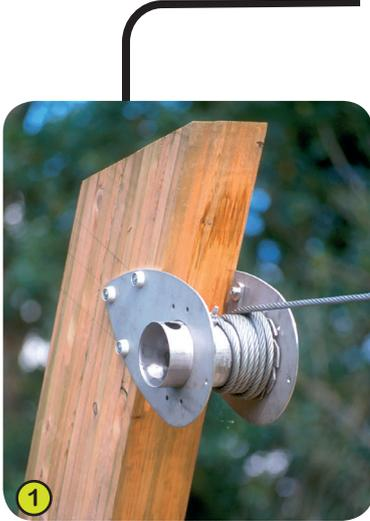
1- **Les poutres cintrées** sont en lamellé-collé traité autoclave et lasuré sur 95 mm d'épaisseur x 200 mm de large x 3,2 m de hauteur. Elles assurent une grande solidité à la structure. Leur ancrage est réalisé sur fourreaux métalliques. Le système avec cliquet permet un réglage aisé de la tension du câble en acier galvanisé d'un diamètre de 10 mm.
