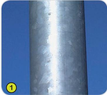
1- Les poteaux en acier galvanisé ont un diamètre de 110 mm.
